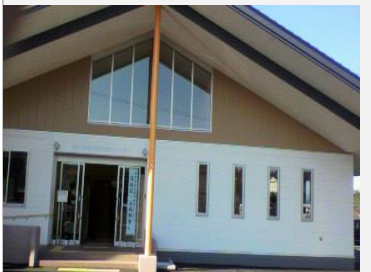
敷地面積は1,994.10㎡ 構造は鉄骨平屋建、延べ床面積は398.95㎡。施設内容は第一集会室198㎡、第2集会室25㎡、料理実習室40㎡。工事費約1億2千680万円
