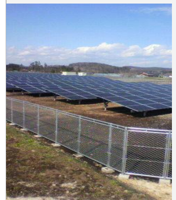
玉山区生出地区のユートランドにあるメガソーラー
