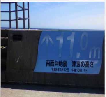
平成5年7月12日午後10時7分北海道南西沖地震による津波高さ11mを示す防波堤のプレート。地震直後は就寝して間もなく、地震が収まってからでは津波から逃げられなかったと話しておりました。
