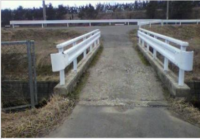
上寺前橋の橋面のコンクリート劣化状況。
