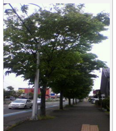
この様に歩道街路樹の幹や枝の間に電線が走っている状況があります。この場合は道路占有者の電線管理者が線の切断や感電事故が予想される場合に自ら剪定を行うことができますが、市民から見れば市のサイドで剪定するものと思っておられた方もあったのではないのでしょうか。今回、私は占有者と協議会を設置し、この様な場合の剪定の協定を締結するよう求めました。
